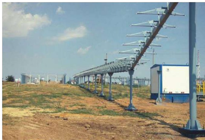
Строительство кабельных эстакад на объекте Заказчика
