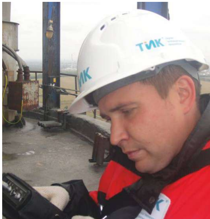
Сотрудники ЛНК за работой на объекте Заказчика
