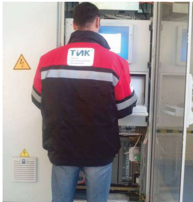
Сотрудники ЛНК за работой на объекте Заказчика
