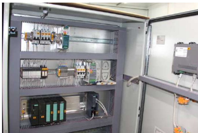
Шкаф системы АСУТП в процессе сборки
