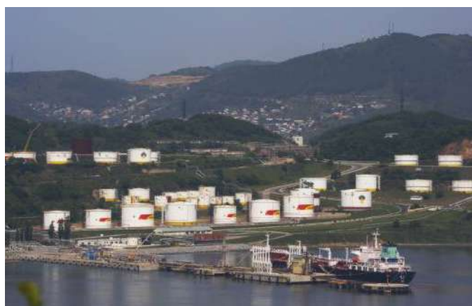
Нефтяной терминал «Роснефть-Находканефтепродукт» (Приморский край)
