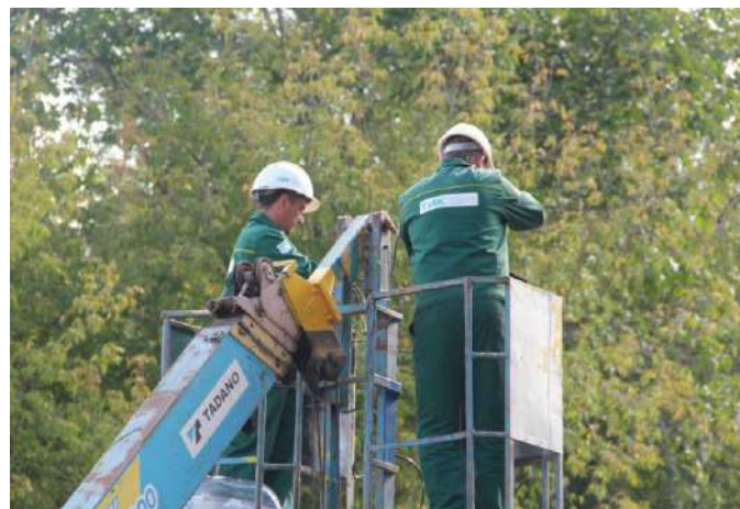
Сотрудники Департамента СМР проводят высотные работы на объекте Заказчика
